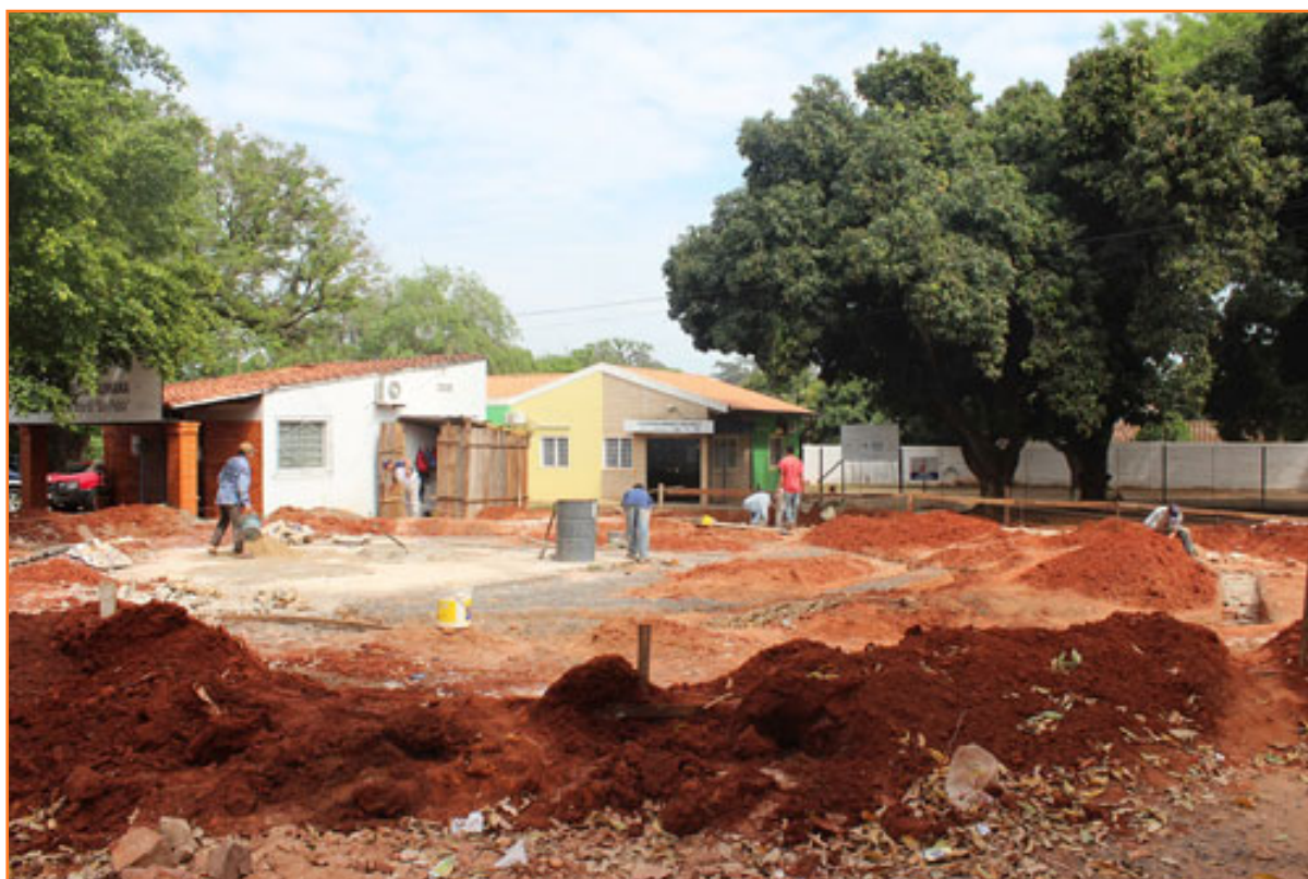
Las obras del nuevo espacio para los BLH en progreso
