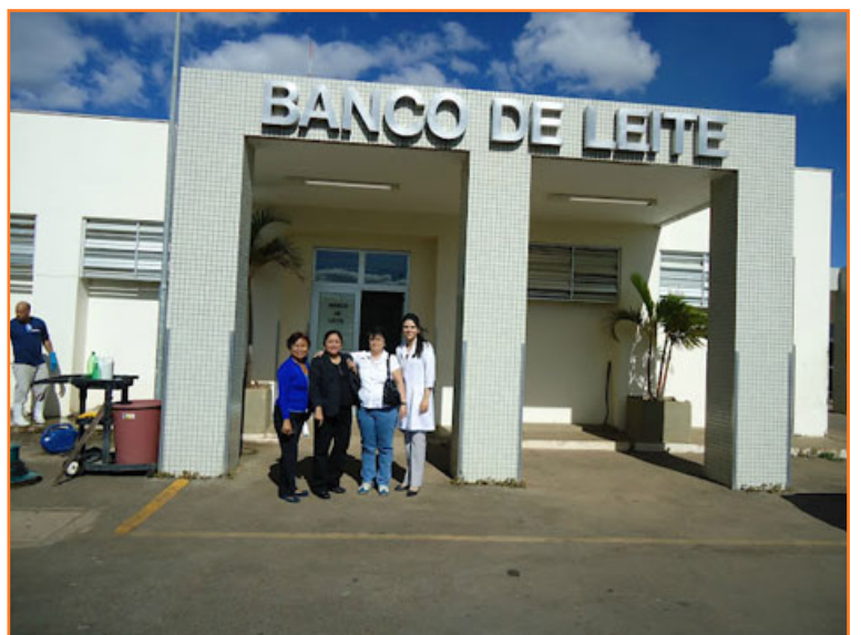
En el BLH del Hospital Regional de Paranoá
